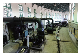
⑤ 旧台北市浄水場
